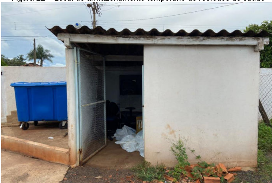
Figura 22 – Local de armazenamento temporário de resíduos de saúde
